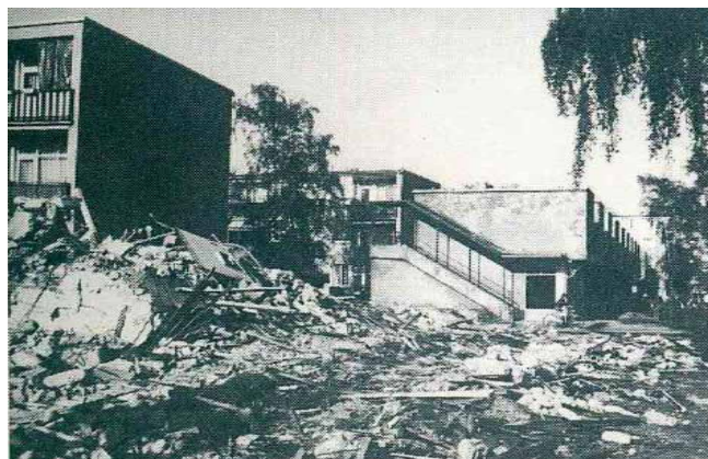
Der Teilabriss der Hellerhofsiedlung 1976 (Foto: Mohr/Müller: Funktionalität und Moderne, S. 213)
