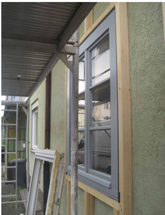
Die Fassade während der Restaurierungsarbeiten und danach (Fotos: Cornelius Boy)
